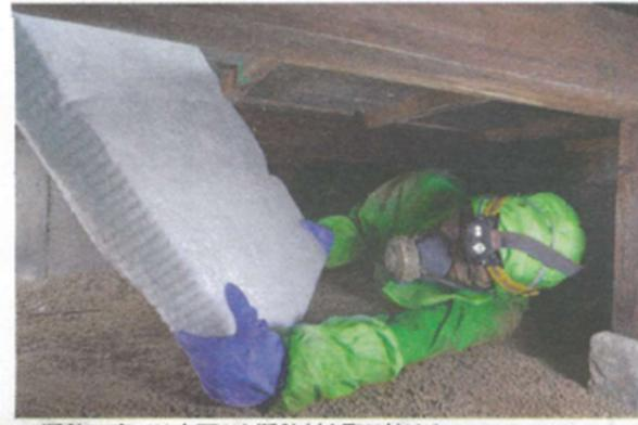
▲断熱工事では床下から断熱材を取り付ける
