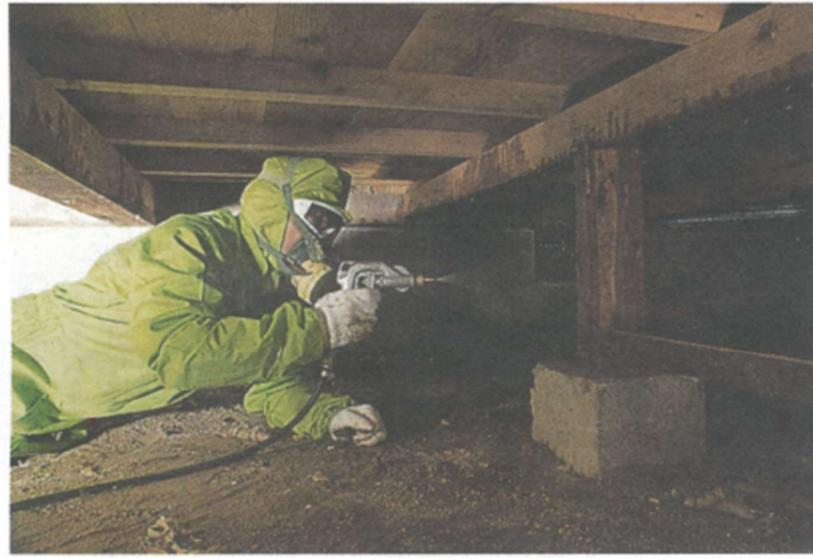
▲シロアリ防除工事の様子。床下に潜って、薬剤を吹き付ける
